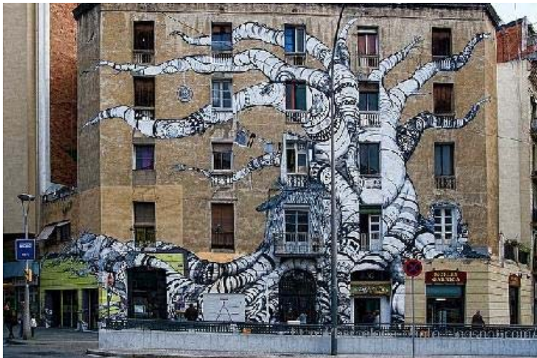
Façana de La Carboneria. Casa okupada del carrer Floridablanca - Urgell a finals del 2008, que s'ha convertit en un important centre social.
